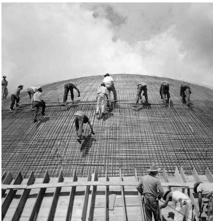
Imagem 11: Trabalhadores nas obras do Palácio do Congresso Nacional, em fase final de 127 concretagem, c. 1959. Fonte Marcel Gautherot. Acervo Instituto Moreira Salles © versão digital editada: Lina Kim e Michael Wesely©
